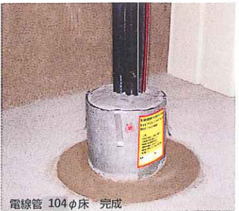
電線管 104φ床 完成
